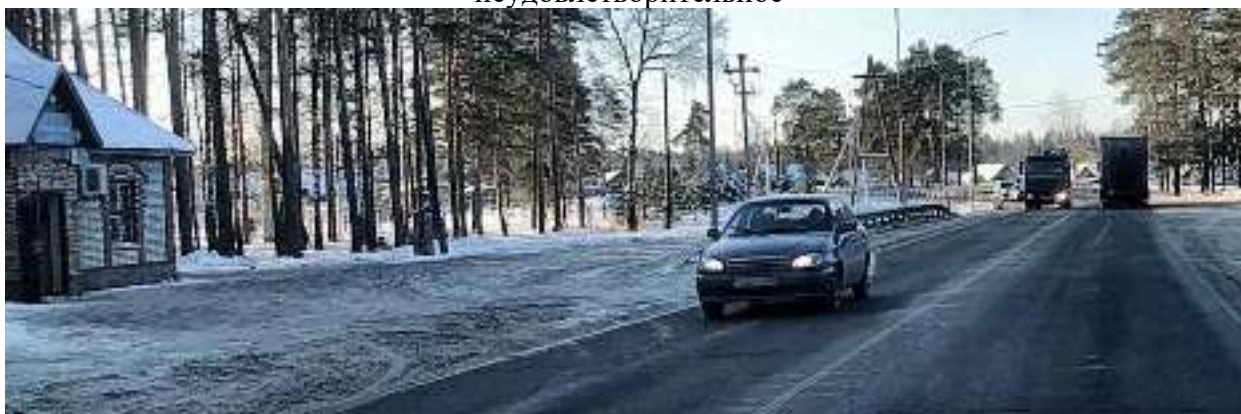
Рис.7 Км 202+900 справа (ПК 0+52) Примыкание к кафе имеет а/б покрытие. Состояние неудовлетворительное
