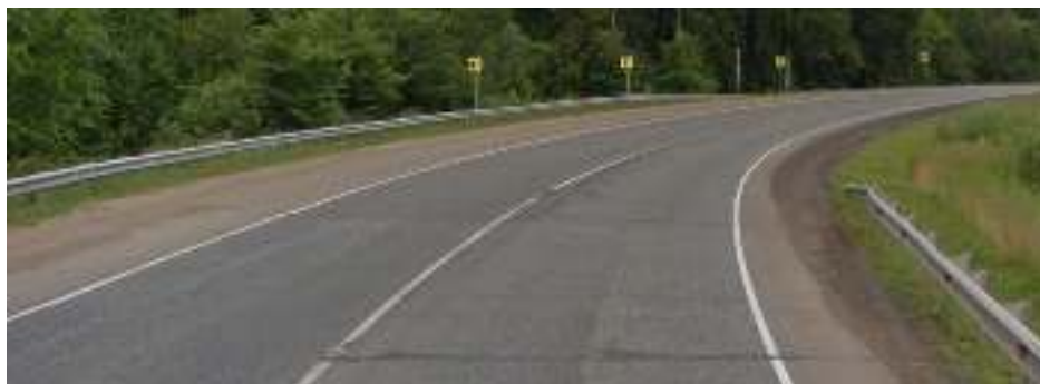
Рис. 1 Начало капитального ремонта. Эксплуатационный км 201+000.
