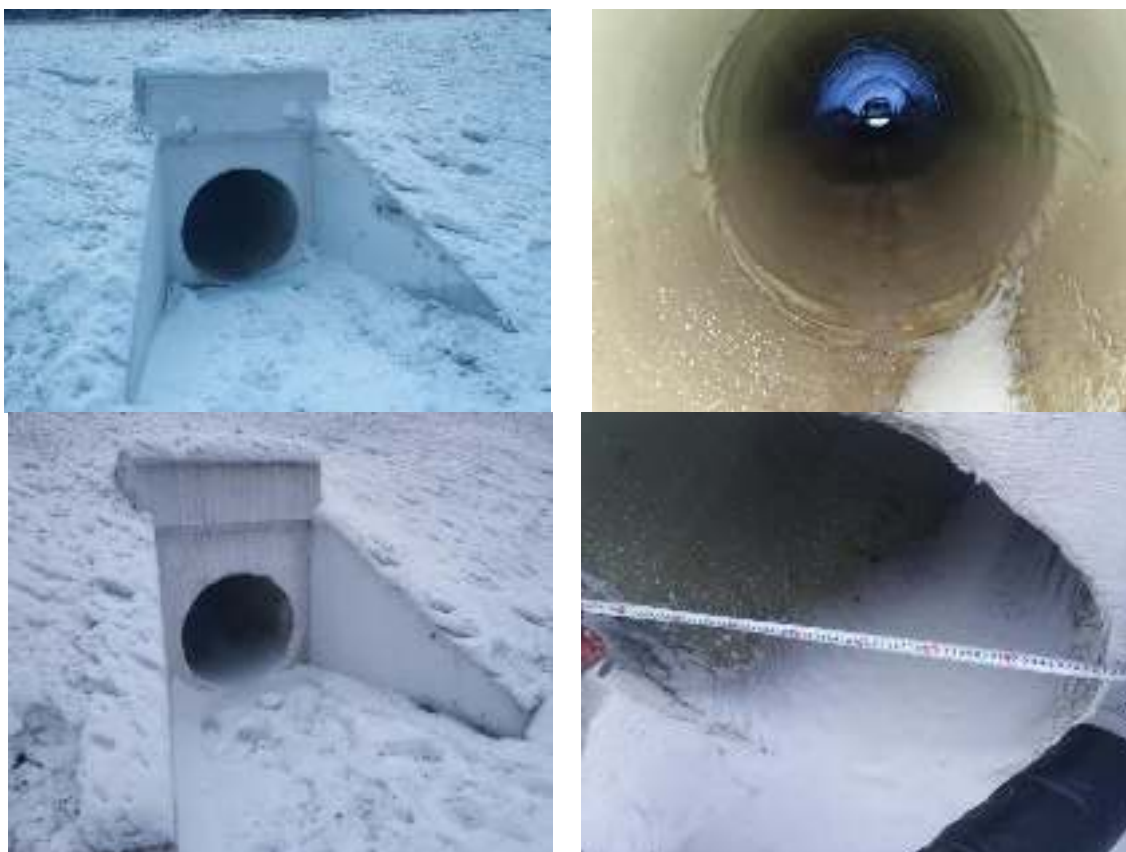
Рис. 14 Км 209+065 ПК20+05 по основной трассе. Труба d=1.0 Водоток – лог.
