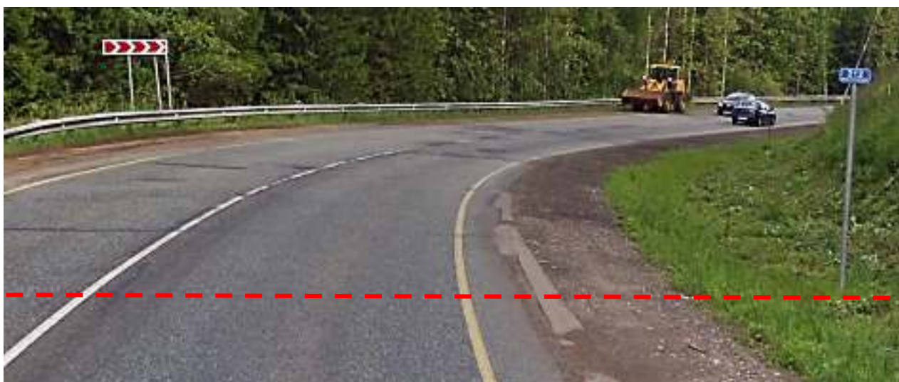
Рис. 35 Конец участка капитального ремонта. Эксплуатационный км 212+000.
