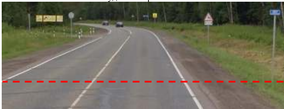
Рис. 25 Конец участка капитального ремонта. Эксплуатационный км 207+000.
