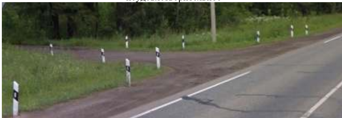
Рис.14 Км 204+598 слева. Примыкание к базе отдыха имеет а/б покрытие. Состояние неудовлетворительное
