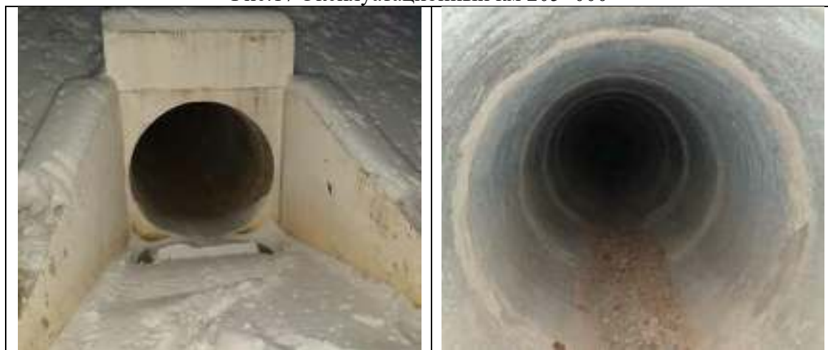
Рис. 18 Км 205+692 (ПК 48+30) по основной трассе Труба d=1.0 Состояние удовлетворительное.
