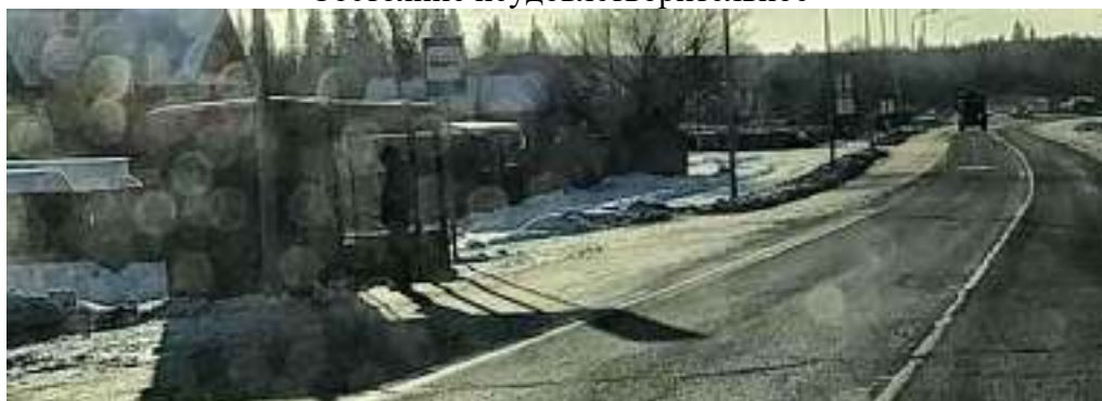
Рис.5 Км 202+532 (справа). Автобусная остановка. Наименование «Сельчка». Состояние неудовлетворительное
