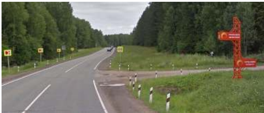
Рис.10 Км 208+456 ПК14+14 справа. Примыкание в детский лагерь имеет а/б покрытие. Состояние неудовлетворительное
