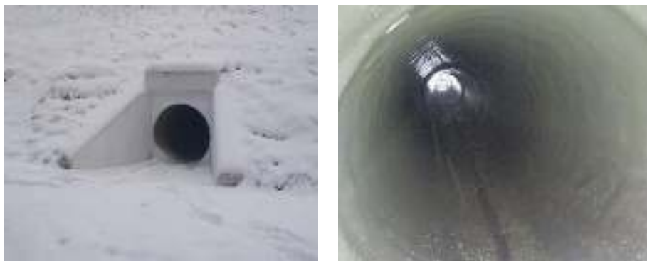
Рис. 29 Км 210+964 ПК37+51 по основной трассе. Труба d=1.0 Водоток – Лог.
