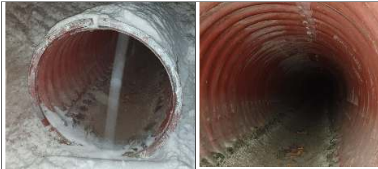
Рис. 16 Км 204+887 (ПК40+21) по основной трассе Труба d=1.0 Состояние удовлетворительное.
