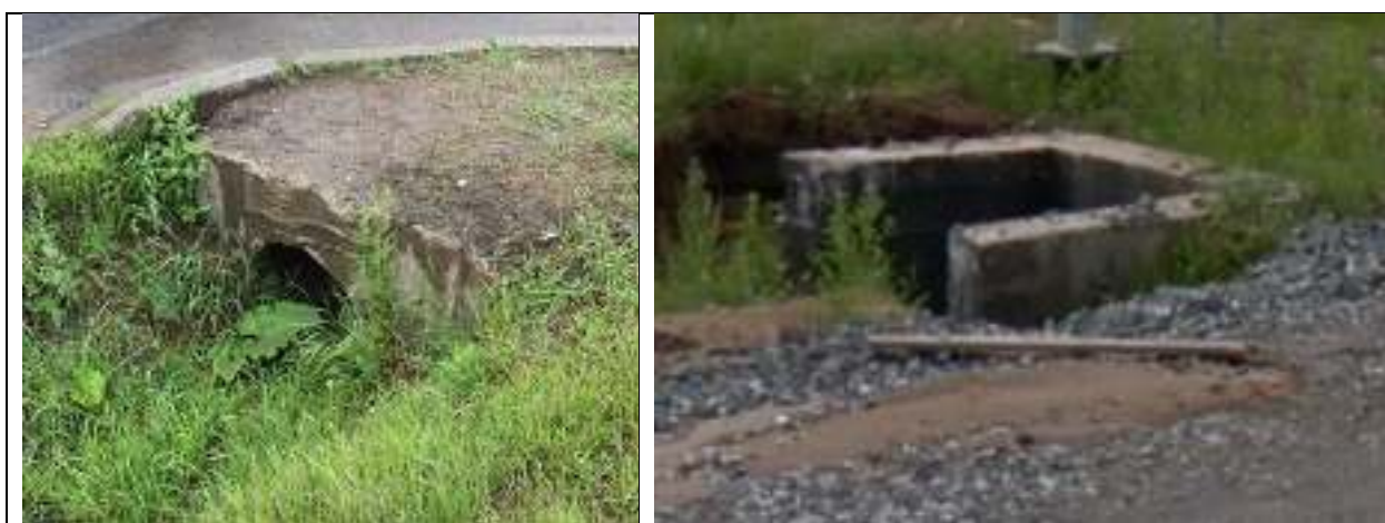
Рис. 25 Км 210+378 ПК31+68 справа. Труба d=0.5 Водоток – правый кювет.
