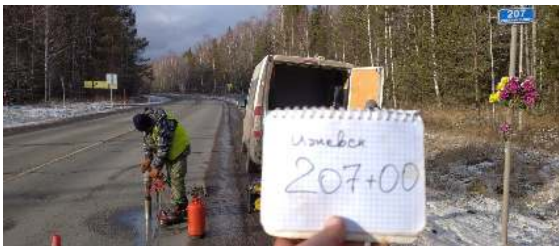
Рис. 1 Начало капитального ремонта. Эксплуатационный км 207+000.
