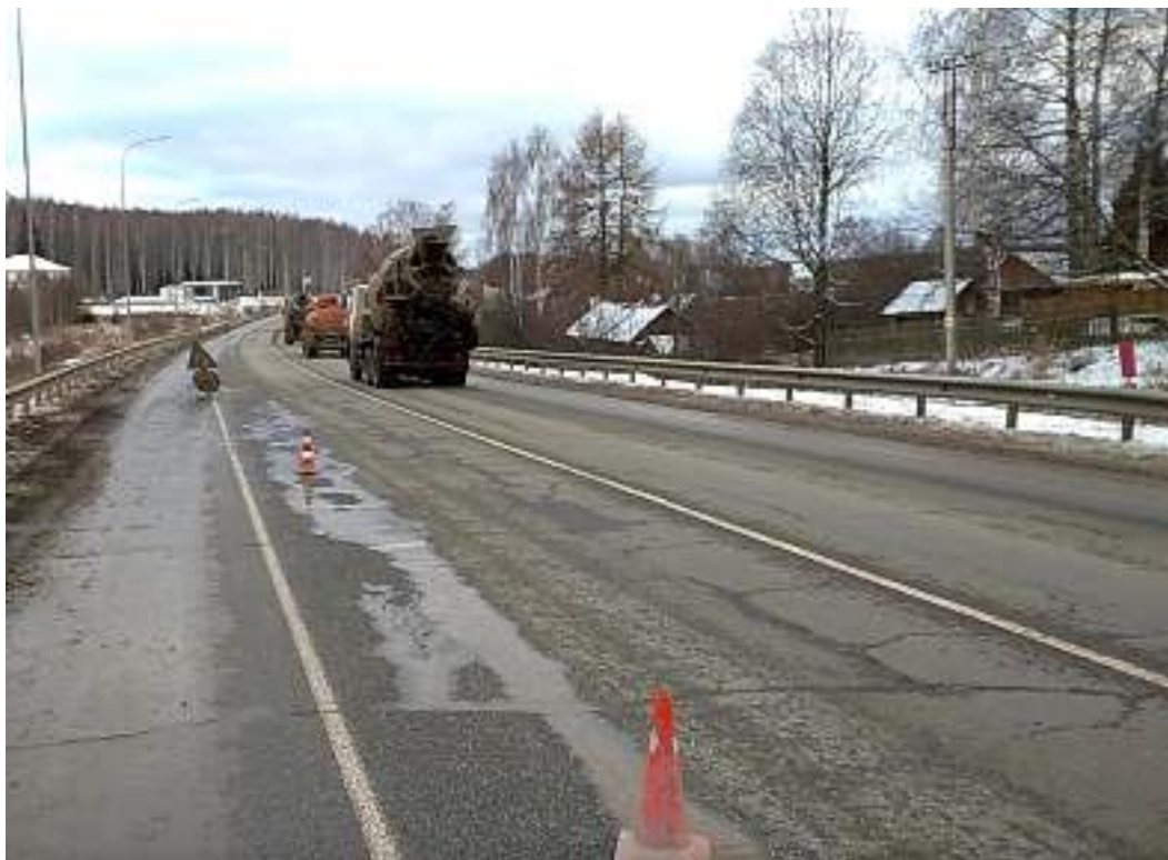
Рис.2 Состояние покрытия. Выкрашивание покрытия, продольные и поперечные трещины на полную глубину ДО, колея - 5-7 см.
