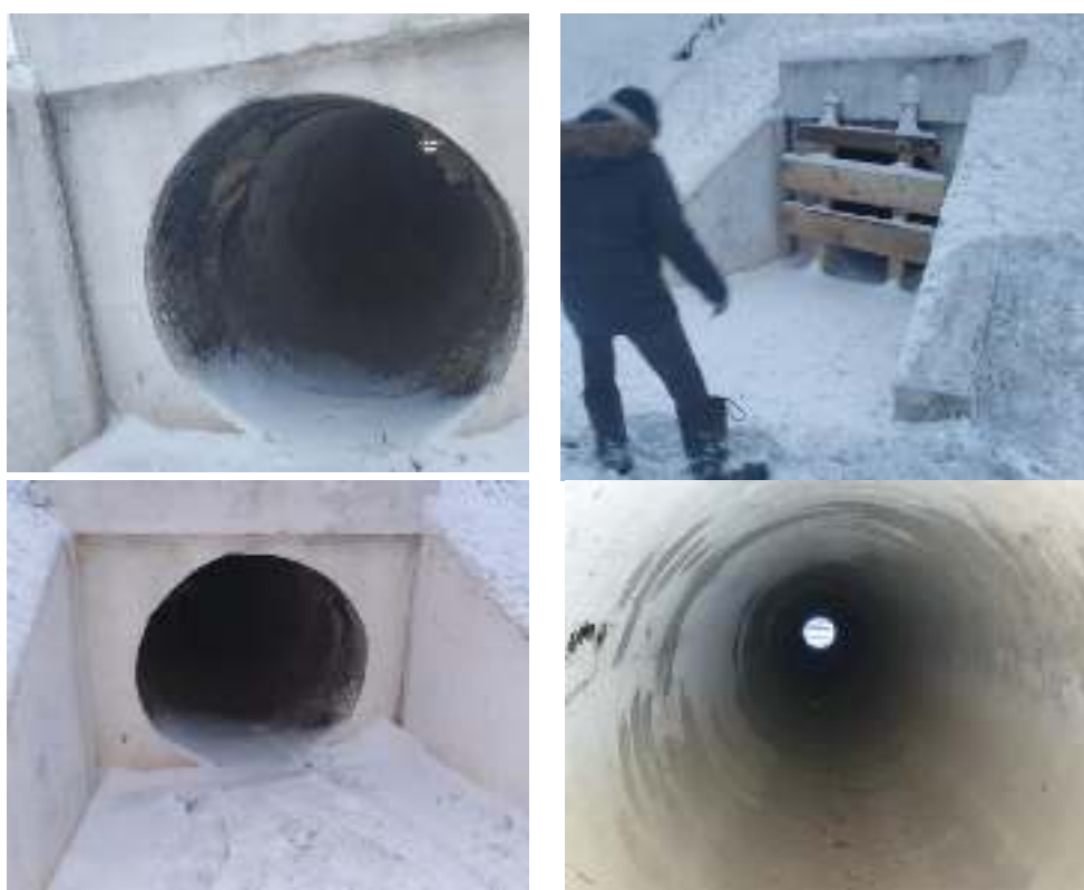
Рис. 15 Км 209+769 ПК27+45 по основной трассе. Труба d=1.0 Водоток – лог.
