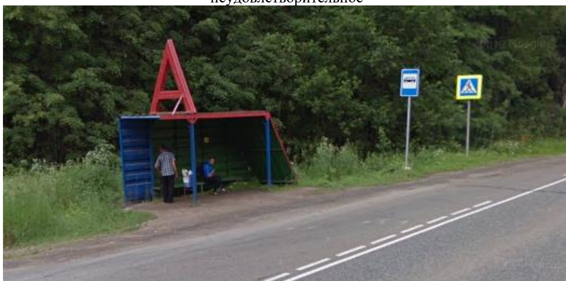
Рис. 5 Км 207+295 (слева). Автобусная остановка. Наименование «Чур». Состояние неудовлетворительное
