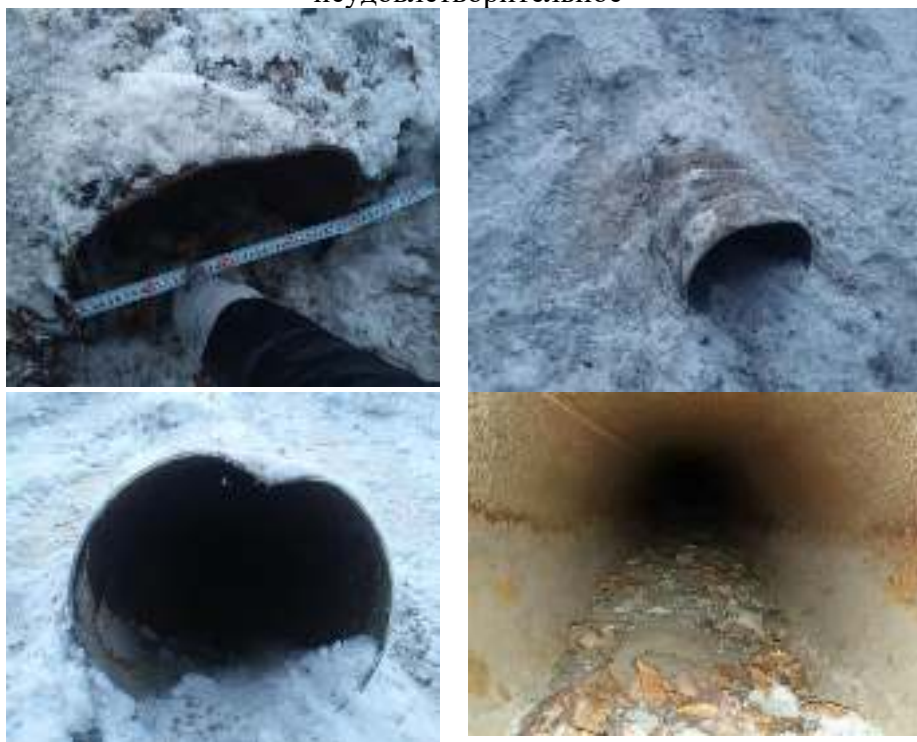
Рис. 9 Км 208+060 ПК10+16 по основной трассе. Труба d=0.4 Водоток – лог.
