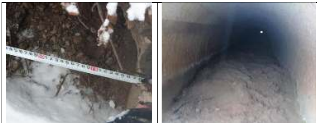
Рис. 32 Км 211+528 ПК43+59 справа. Труба d=0.8 Водоток – правый кювет.
