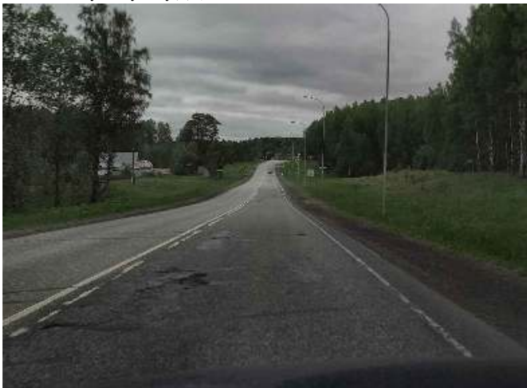
Рис.2 Состояние покрытия. Выкрашивание покрытия, продольные и поперечные трещины на полную глубину ДО, колея - 5-7 см.
