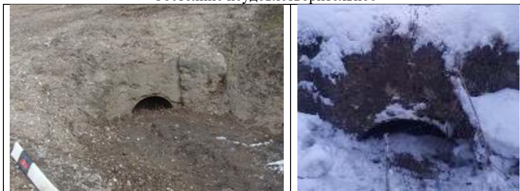
Рис. 11 Км 208+456 ПК 14+14 Справа. Труба d=0.5 Водоток-правый кювет
